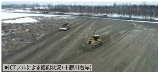
●ICTによる掘削状況(十勝川右岸)
