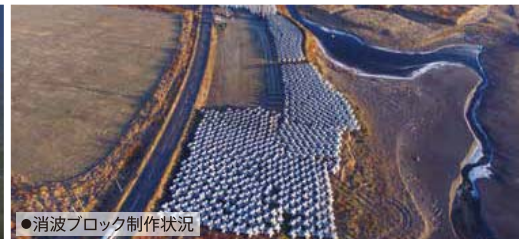
●消波ブロック制作状況
