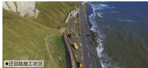
●迂回路施工状況
