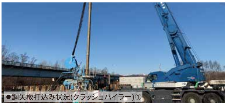
●鋼矢板打込み状況(クラッシュパイラー)②
