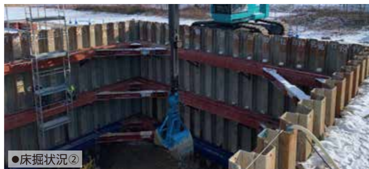
●鋼矢板打込み状況(クラッシュパイラー)②
