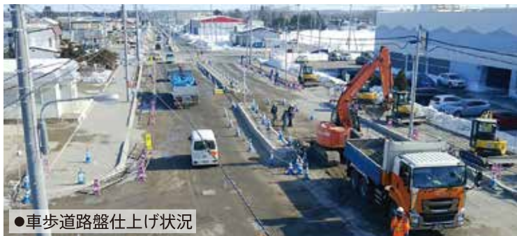
●L型擁壁ブロック設置状況
