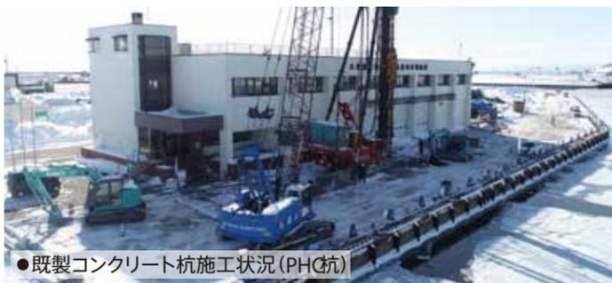
●既製コンクリート杭施工状況 (PHC杭)
