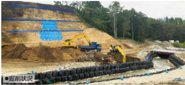
●床掘削状況
