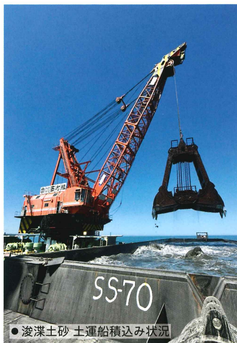
● 浚渫土砂 海上運搬状況(土運船開閉前)
