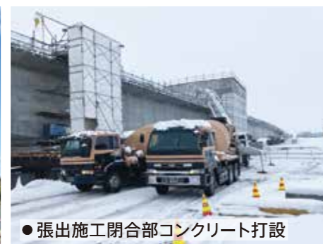
● 張出施工部コンクリート打設
