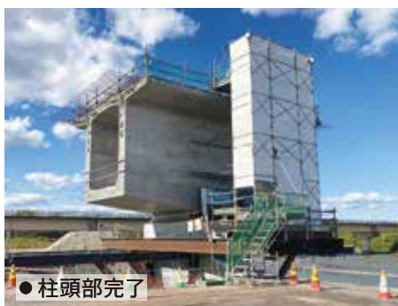
● 柱頭部コンクリート打設
