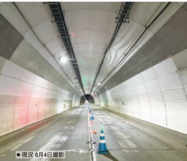
● 漏水防止板設置
