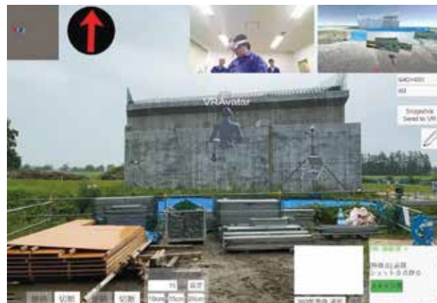
現場のタブレットで見る画面
