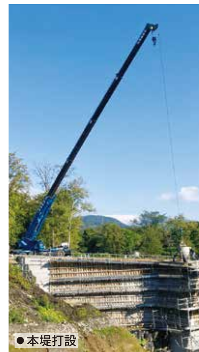
●残存型枠建込み
